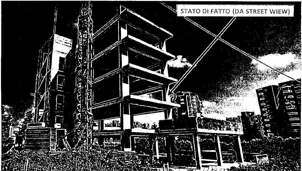
Figura 5-vista da terra dell'edificio realizzato con la sola struttura
